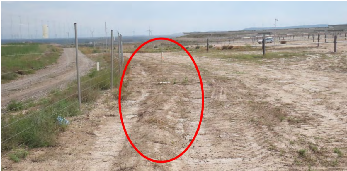
Ilustración 3. Rellenado de regueros generados por lluvias intensas.
