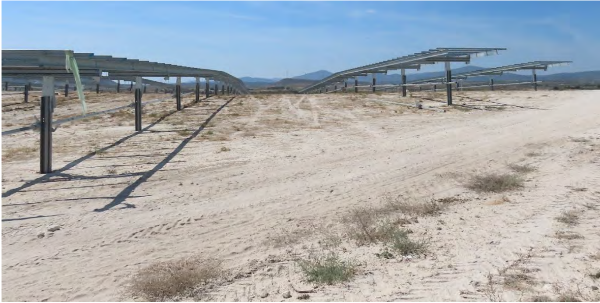
Ilustración 2. Instalación de estructuras de los seguidores.
