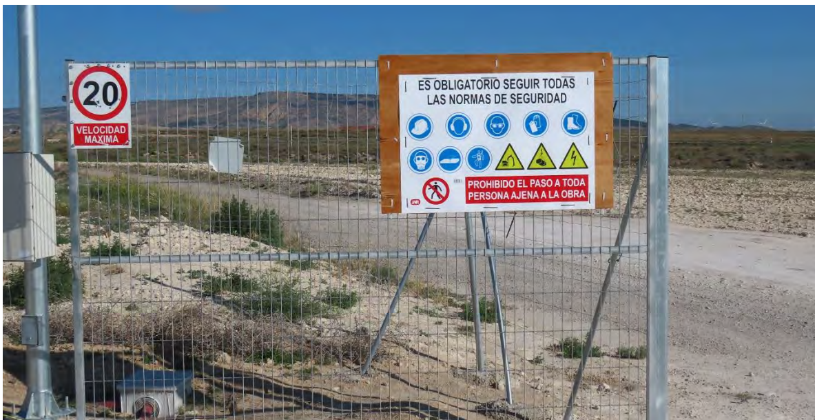
Ilustración 4. Señalización de la obra.
