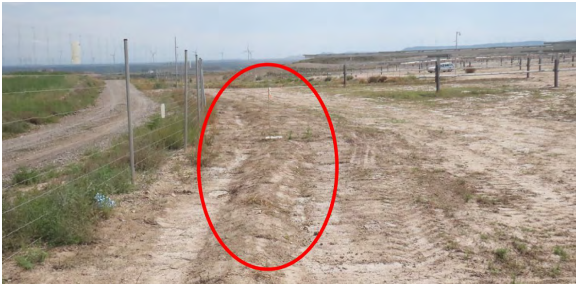
Ilustración 5. Rellenado de regueros generados por lluvias intensas.
